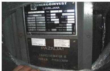
Identifikacione pločice na transformatorima
