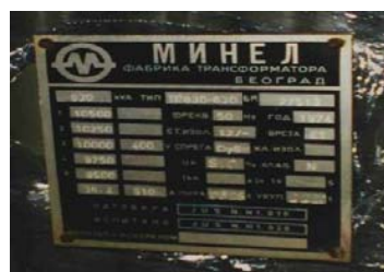
Identifikacione pločice na transformatorima
